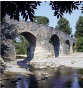
Réhabilitation et maintien en fonction avec des restrictions d'usage: ce pont sur la Thur, datant de la fin du Moyen Age, sis à Bischofszell TG, a été rénové en 2000/2005; on a stabilisé la maçonnerie, assuré l'étanchéité, revu les dispositifs d'évacuation des eaux et posé un revêtement pour piétons (Andres Betschart).
