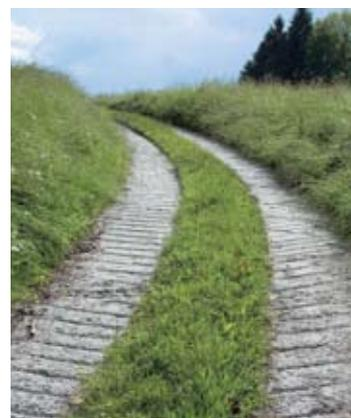
Chemin d'exploitation agricole, habilement aménagé à l'aide de bandes de roulement en béton, pourvues de stries pour une meilleure adhérence. Fahrmi BE (ViaStoria/Guy Schneider).
