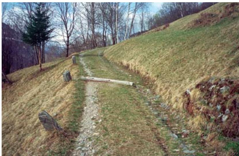
Au-dessus de Poz, la voie charretière d'Arvigo à Braggio, dans le val Calanca GR, est bordée de talus sur les deux côtés. Autres éléments constitutifs de cette voie: les murs de soutènement côté pente, les traverses, les pierres bordières (ViaStoria/Guy Schneider).
