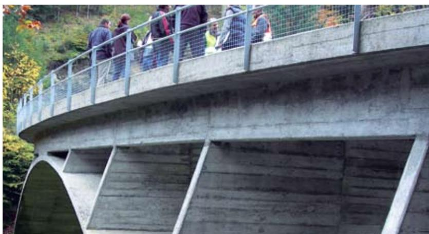
Pont avec des garde-fous en tubulaires métalliques rapportés, ne correspondant plus aux normes de sécurité actuelles. Le treillis en fil de fer de la partie basse sert de protection aux piétons. Avec la bordure de sécurité, cette disposition assure aussi la résistance aux chocs. Schwandbachbrücke de Robert Maillart à Hinterfultigen BE (EPFL/Eugen Brühwiler).
