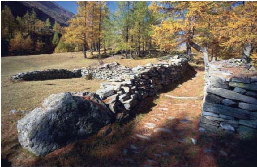
Le chemin Stockalper, chemin muletier du XVII<sup>e</sup> siècle, à Engi au sud du col du Simplon VS. Sa largeur et sa configuration sont adaptées au portage des marchandises par des bêtes de somme, alors largement répandu, et correspondent aux moyens techniques de l'époque en matière de construction routière (ViaStoria/ Heinz Dieter Finck).
