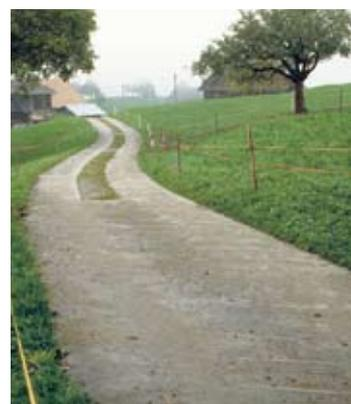
Le tracé de ce chemin rural, qui épouse avec délicatesse les formes du terrain, n'a pas été modifié par la pose d'un revêtement en dur. Pas de géométrisation, en dépit d'une largeur constante et d'un bétonnage bord à bord, qui, plus loin, est interrompu par une bande centrale herbeuse. Canton d'Obwald (ViaStoria/Arne Hegland). Voir p. 61.
