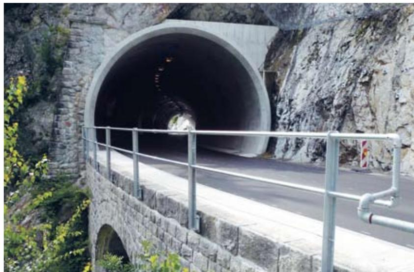
Rénovation à l'aide de moyens contemporains: portail oriental du tunnel de Wyler sur la route du col du Susten, après sa rénovation en 2006/2007. Des vestiges de l'ancien portail subsistent à côté de la voûte de béton au profil circulaire soigneusement dessiné (ViaStoria/Guy Schneider).
