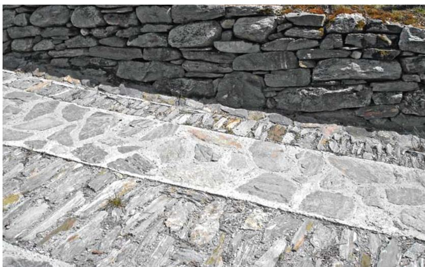
Stabilisation innovante : les bandes de roulement sont des dalles de pierre jointoyées, tandis que la bande centrale est pavée.
