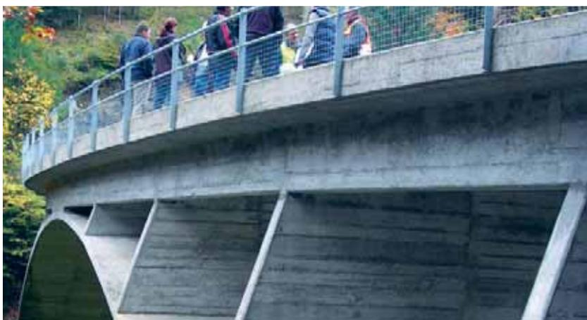
Ponte con ringhiera metallica tubolare ripristinata, che non risponde più alle norme di sicurezza oggi vigenti. La rete metallica aggiunta nel settore inferiore protegge i pedoni dalle cadute. Con il bordo di sicurezza, in questa situazione anche la protezione antiurto è garantita. Schwandbachbrücke di Robert Maillart presso Hinterfultigen BE (EPFL/Eugen Brühwiler).
