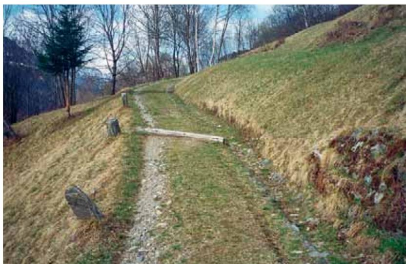
Sopra Poz, la carrareccia di mezzacosta da Arvigo a Braggio, in Val Calanca GR, presenta scarpate su entrambi i lati. Altri elementi viari sono il muro di sostegno a monte, la canaletta trasversale e i cippi (ViaStoria / Guy Schneider).
