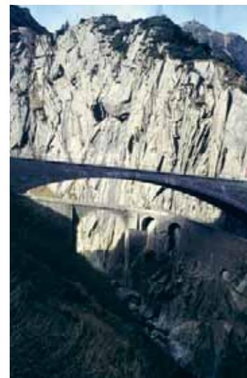
Decongestionamento con una nuova costruzione. Il Ponte del Diavolo sulla strada del Gottardo del 1830 non era più adeguato al traffico automobilistico, da cui fu sgravato con la costruzione del nuovo ponte stradale del 1955/56. Gola della Schöllenen UR (ViaStoria/ Cornel Doswald).
